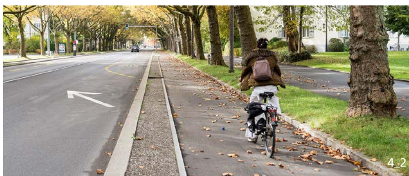
La piste cyclable unidirectionnelle attrayante longe un axe principal urbain avec une allée et une séparation des modes de transport (Winkelriedstrasse, Berne).
