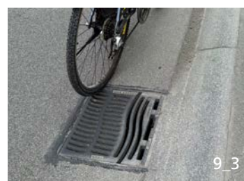
Grille d'égout adaptée aux vélos (Ipsach)
