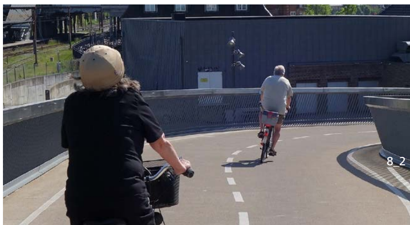
La ligne de direction sur la piste cyclable bidirectionnelle délimite les voies de circulation (Odense, Danemark)
