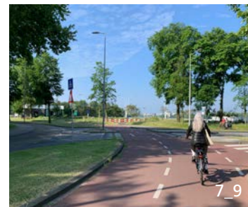
Giratoire avec piste cyclable bidirectionnelle en retrait et prioritaire (Amsterdam [Sloterplas] au carrefour Burgermeester van de Pollstraat / oostover, Pays-Bas)
