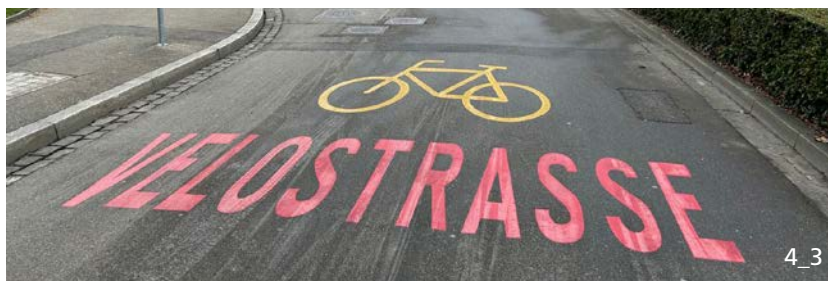
En milieu urbain, les voies express cyclables sont souvent aménagées sur des « rues cyclables » compatibles avec le quartier. L'utilisation coordonnée du marquage au sol et de la signalisation assure la gestion des flux de cyclistes et facilite leur orientation (Schaffhauser Rheinweg, Bâle).
