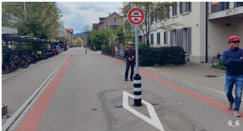
Mit einem kurzen motorfahrzeugfreien Abschnitt wird der motorisierte Durchgangsverkehr auf der Gesamtstrecke auf ein vertragliches Mass reduziert («Veloroute Töss», Tössfeldstrasse, Winterthur).
