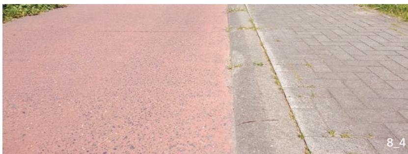
Beispiel für einen flächig rot eingefärbten Belag auf einer Velobahn (Brügge, Belgien)
