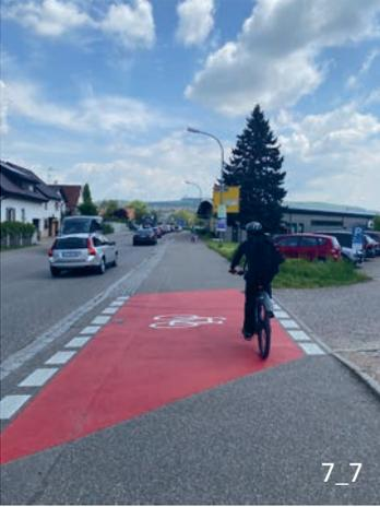
Strassenbegleitende Querung bei einer untergeordneten Einmündung (Eimeldingen, Deutschland)
