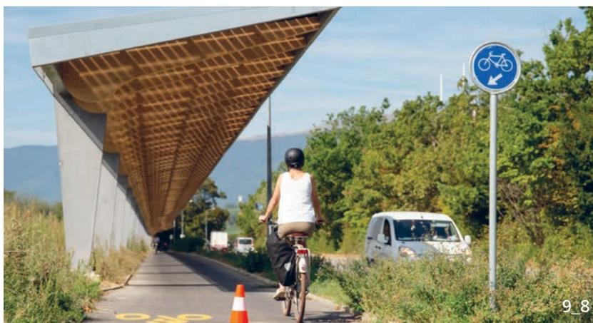
200 m langer Sonnen- und Witterungsschutz mit Solarpanels (200'000 kWh Energieproduktion pro Jahr, Genf)
