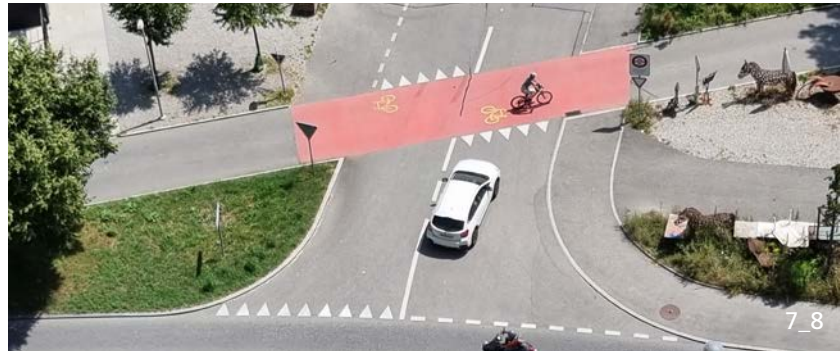
Franchissement cyclable prioritaire et en retrait d'un débouché (Sägegasse, Berthoud)
