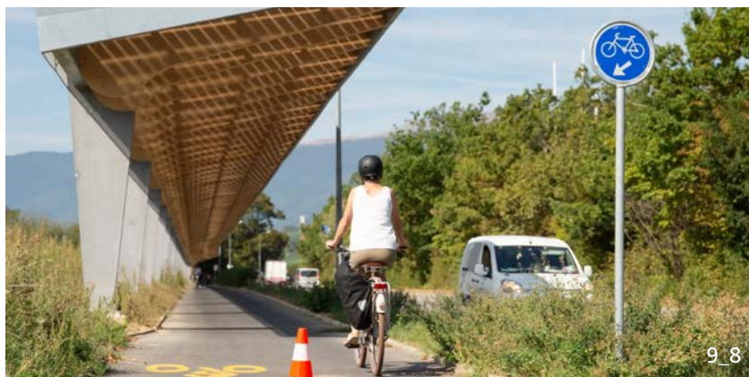
Protection contre le soleil et les intempéries longue de 200 m avec des panneaux solaires (200'000 kWh d'énergie produite par an, Genève)
