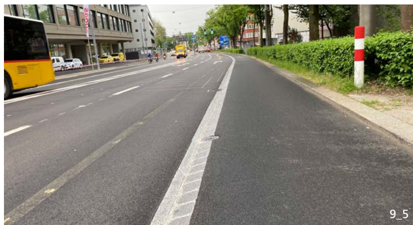
Bordure biaisée entre la chaussée et la piste cyclable unidirectionnelle (Murtenstrasse, Berne)
