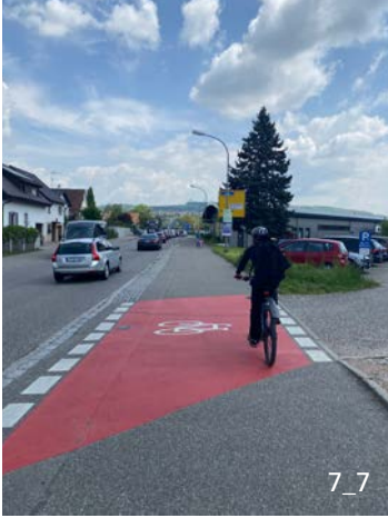
Franchissement cyclable, le long de la route, du débouché d'une route secondaire (Eimeldingen, Allemagne)
