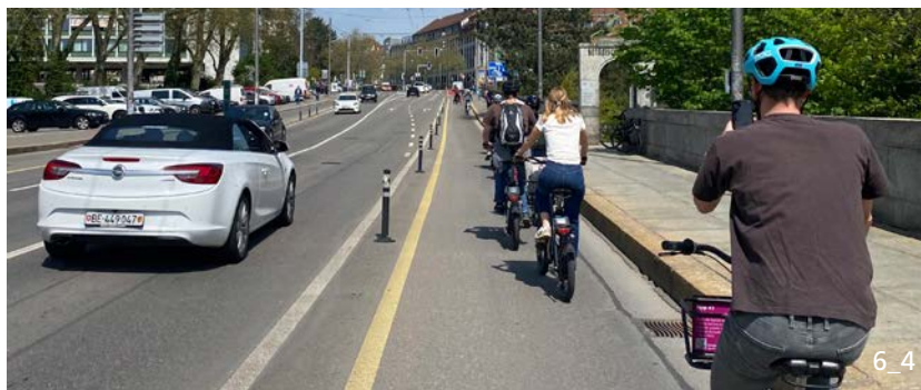
Bande cyclable protégée séparée des voies du trafic motorisé par des potelets (Lorrainebrücke, Berne)
