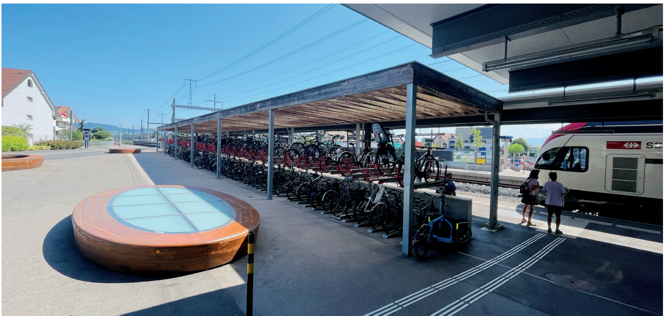
Fig. 3 : Nouvel aménagement de la place de la gare, avec stationnement vélo (photo : Laurent Dutheil)
