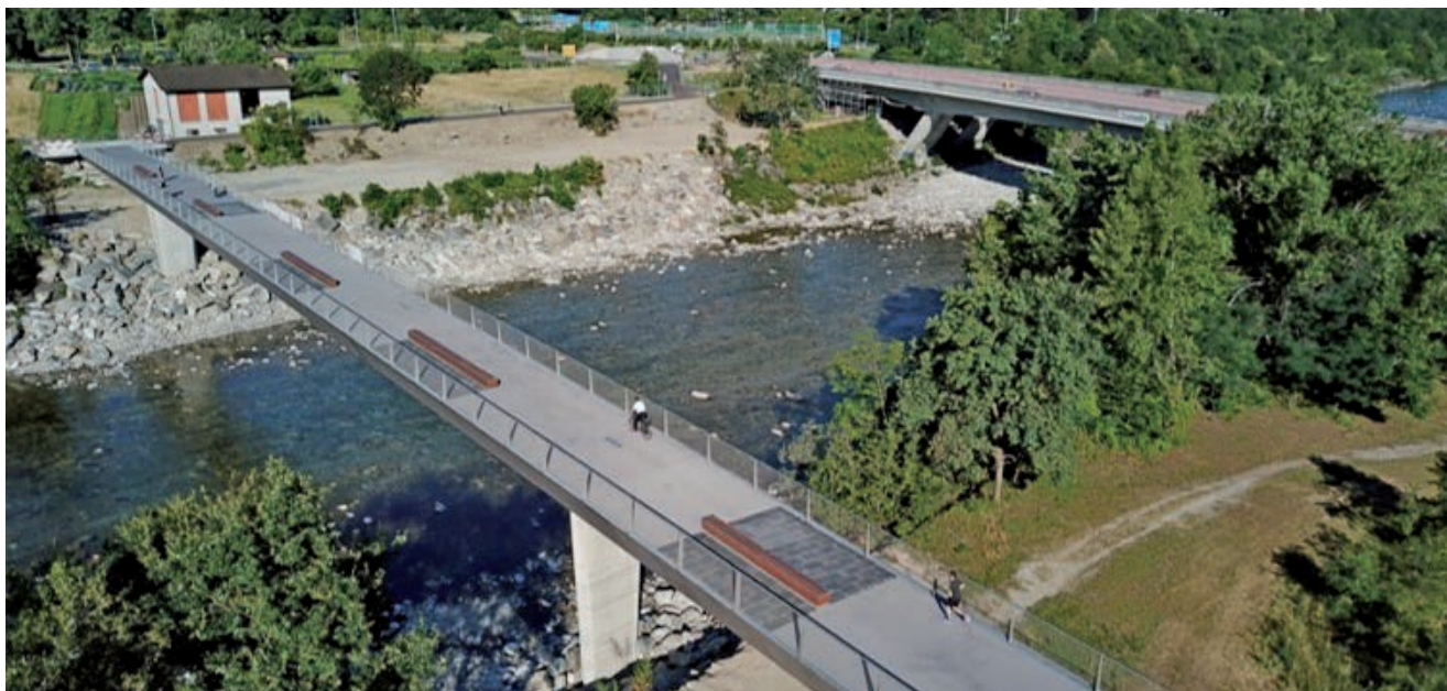
Abb. 2 Maggia-Passerelle zwischen Ascona und Locarno, erbaut 2020
