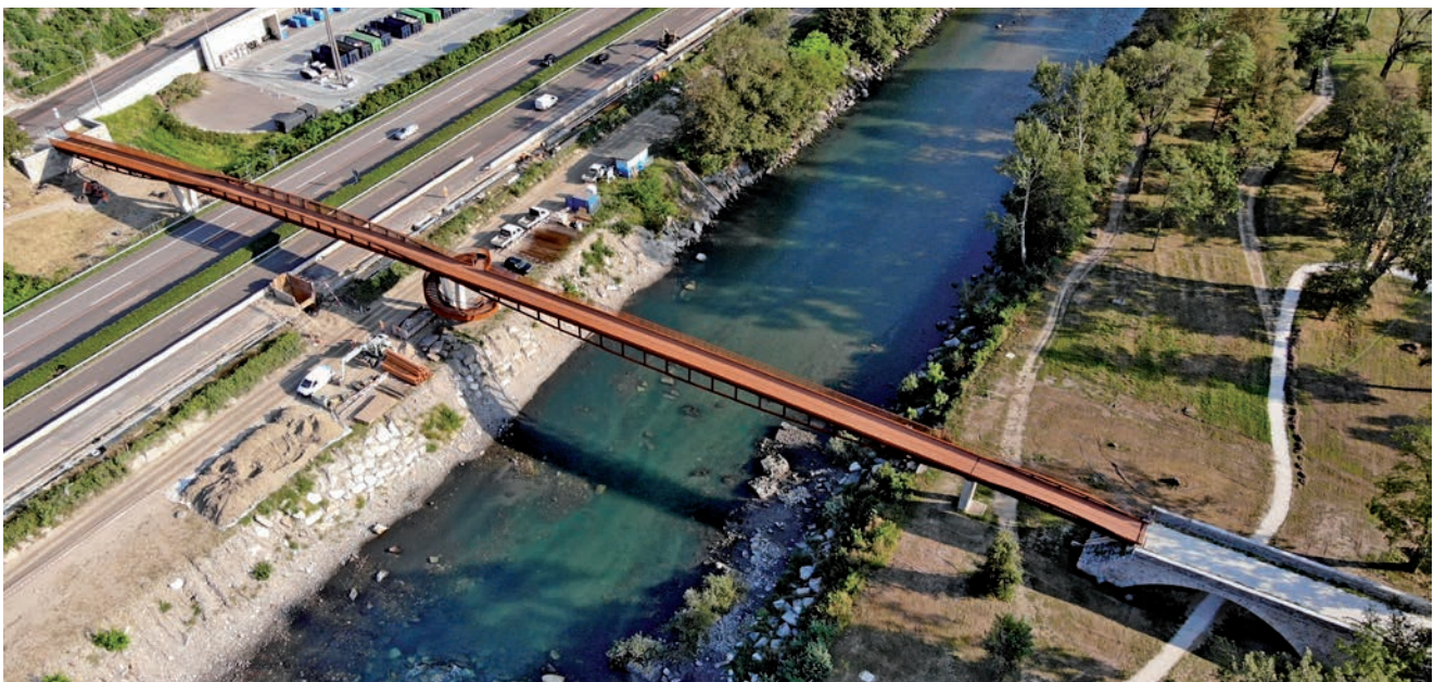
Abb. 3 Tessin-Passerelle Torretta in Bellinzona, erbaut 2022
